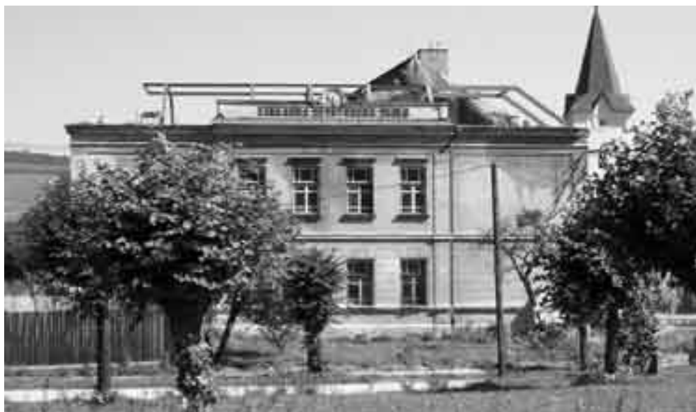
Stará škola počas rekonštrukčných prác.
